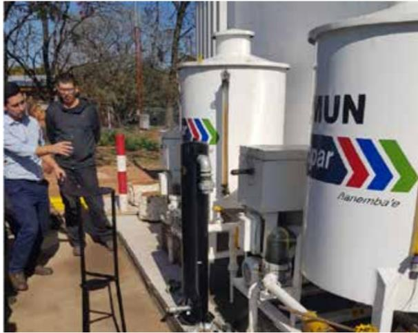
Además, se inició la implementación del microfiltrado, que es un proceso tecnológico que consiste en eliminar todas las partículas sólidas y el agua. La prueba piloto inició con la instalación de un filtro centrifugo, el cual permitirá la eliminación de agua que pueda contener el combustible.
